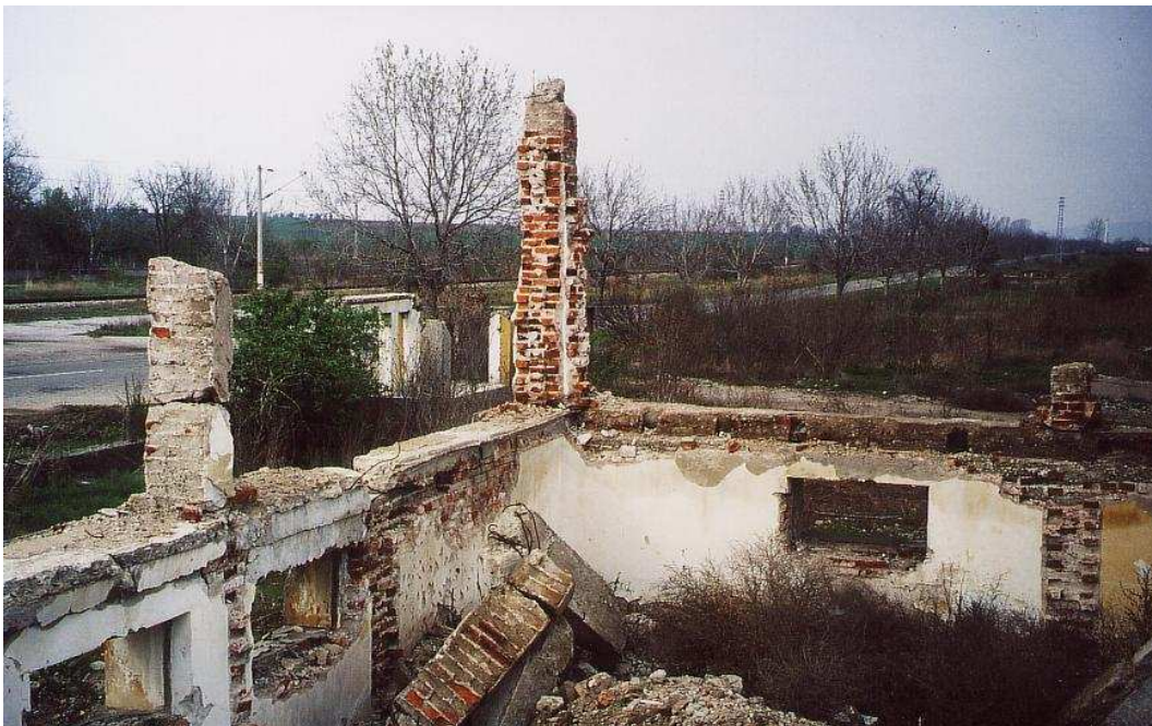
En Bulgarie, tout se vole- Un bâtiment inachevé et toutes les briques ont disparues !
