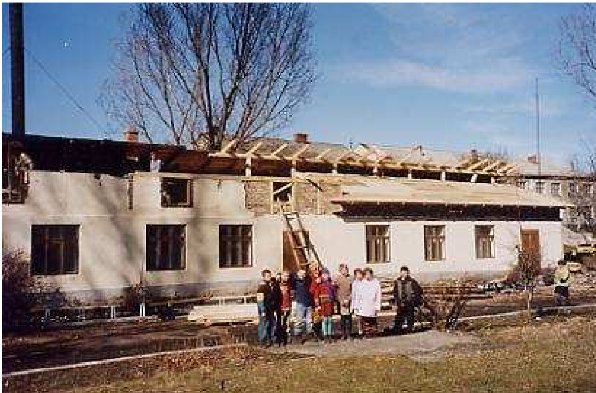
Orphelinat : Réparation d'une toiture soulevée par un ouragan
